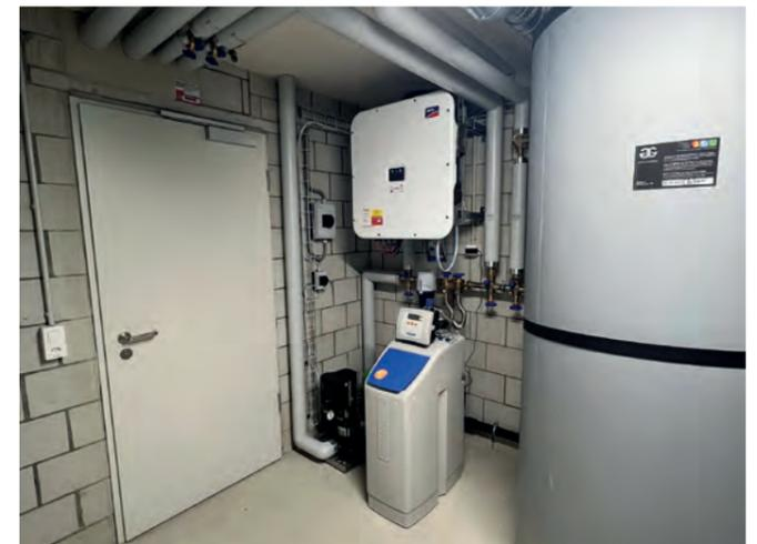
Die Wärmeerzeugung und – Abgabe erfolgt über eine Erdsonden-Wärmepumpe und wird über eine Fussbodenheizung im Gebäude verteilt. Die erstellten Erdsonden haben eine Gesamtlänge von 600m, über diese wird das Mehrfamilienhaus im Sommer auch passiv gekühlt, was die Erdsonden wieder regeneriert.
