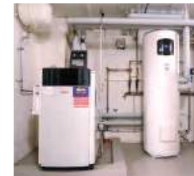
Ölheizung mit Wärmepumpen-boiler
