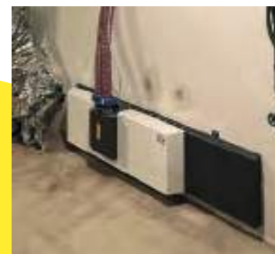
Austragung Pelletheizung
